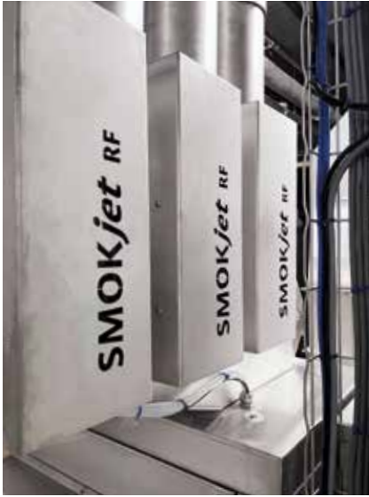
FRIKTIONSRAUCHERZEUGER mit 3-fach Abgang für alternierende Rauchversorgung
